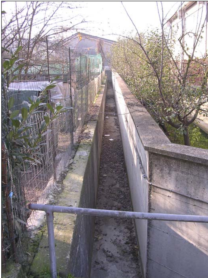
Foto 1: Tratto incanalato del Rio del Vallone, immediatamente a monte di Cavallo Grigio. Si osserva sulla destra (sponda destra idrografica) il muro di sponda che separa il canale dal terreno del capannone limitrofo.
